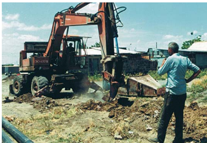
Pose de collecteurs à Gumri.
